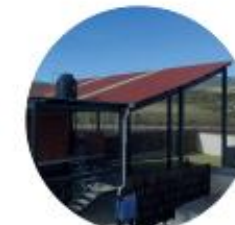
Captación de agua de Lluvia
